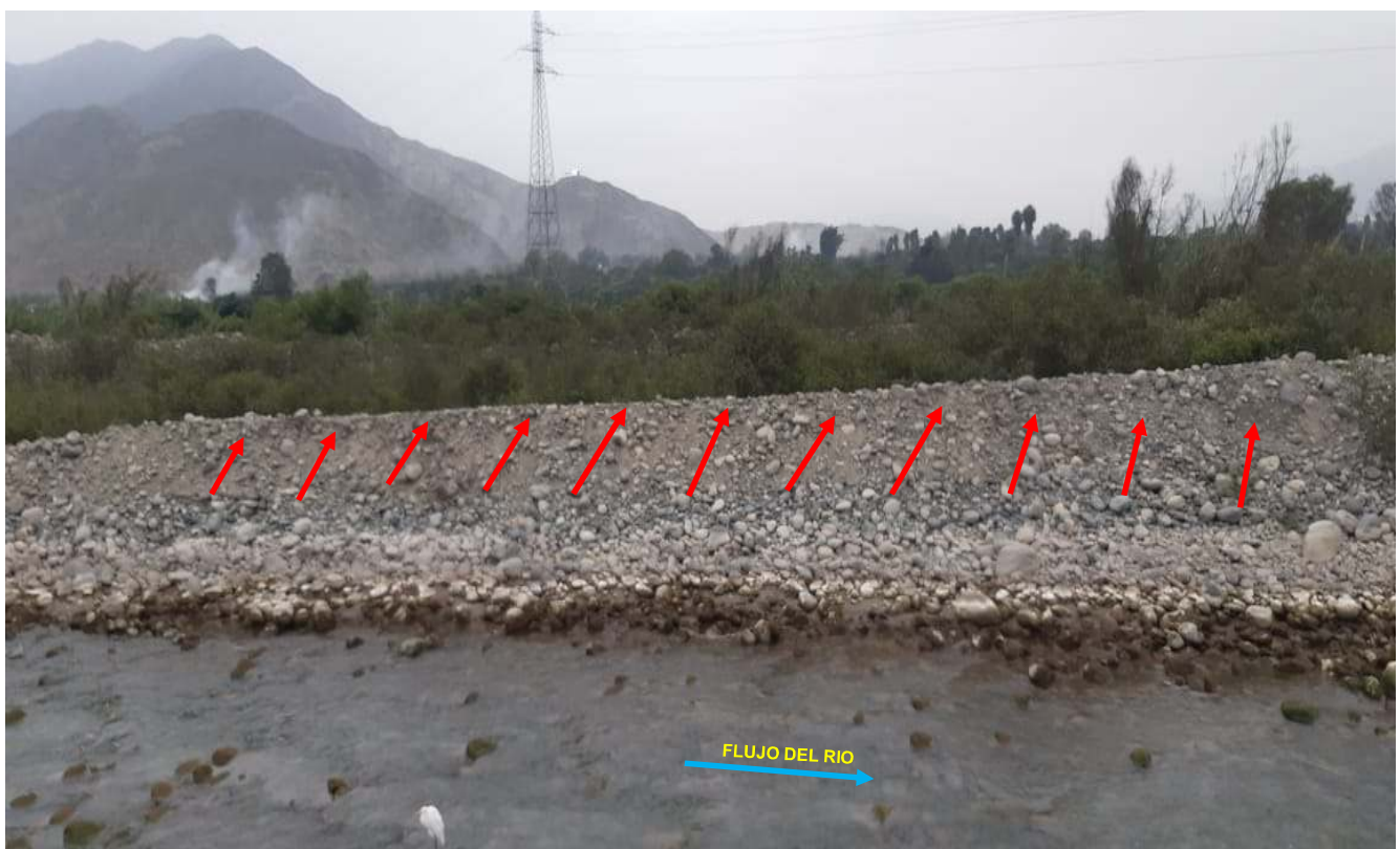
FIGURA N°03: EN LA TEMPORADA DE MAXIMAS AVENIDAS EL RÍO CHANCAY-HUARAL, SE DESBORDA, POR AMBAS MARGENES, EN EL SECTOR SANTA ROSA, DISTRITO DE AUCALLAMA/HUARAL, CUYO TRAMO SE ENCUENTRA COLMATADO Y DESPROTEGIDO,
